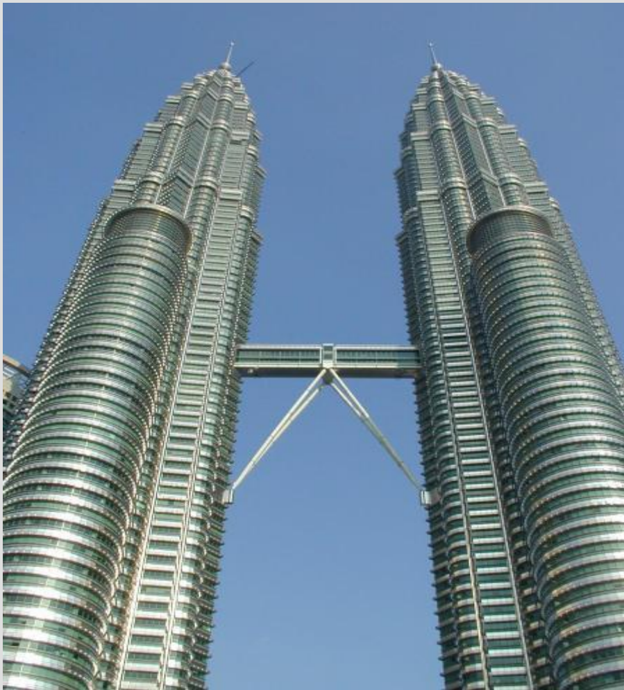
شکل ۲ پل معلق بین دو برج
