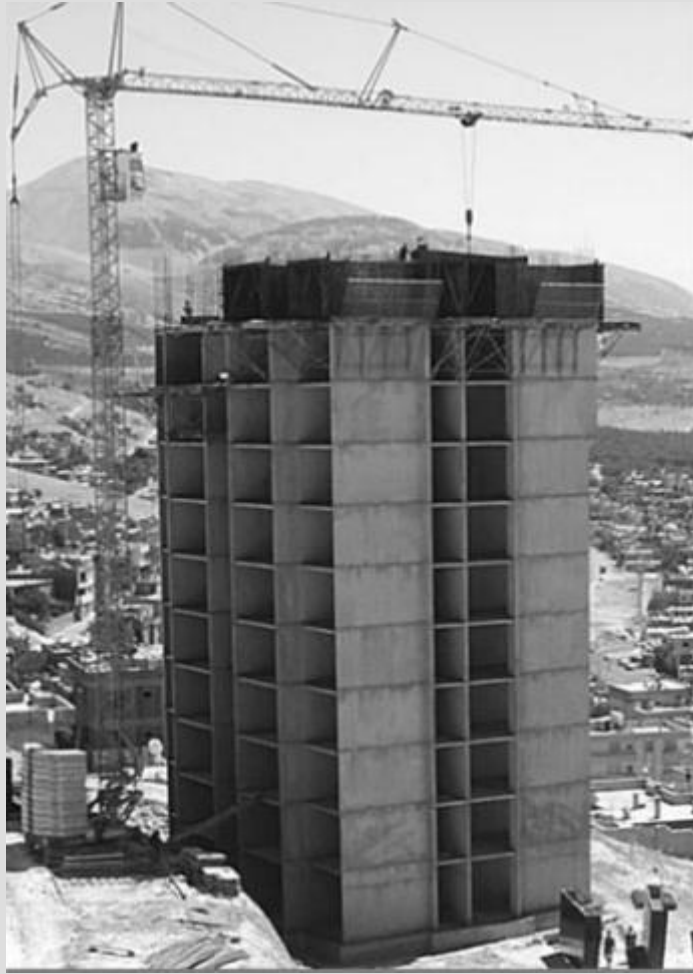
تکنولوژی سیستم قالب تونلی برای افزایش سرعت احداث سازه های بلند
